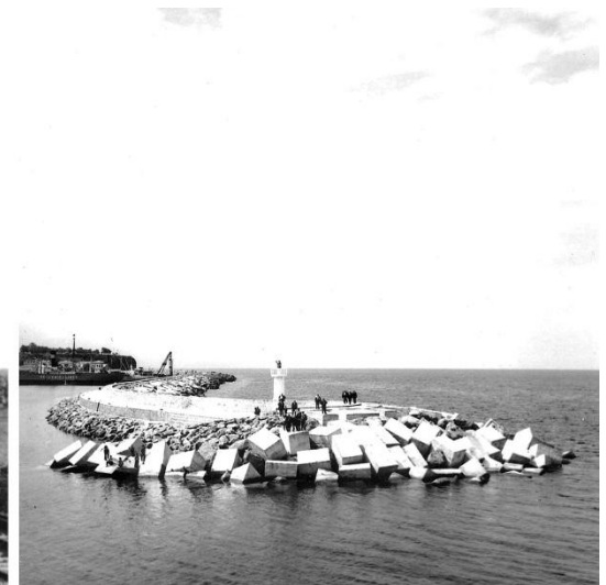
La grande jetée terminée
