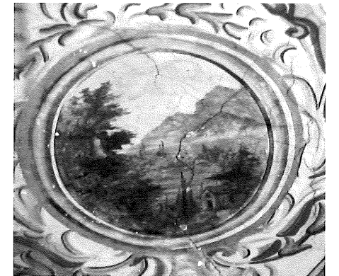
Fot.12. İkiçeşmelik, Şeker Paşa Konağı.
